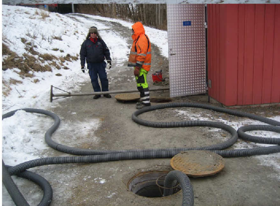
Slangdragning till sugbrunnen med proppat utloppsrör till pumpstationen.
