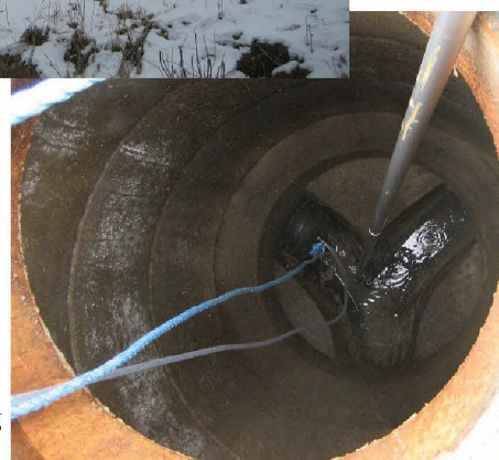
Provisorisk proppning under ombyggnaden
