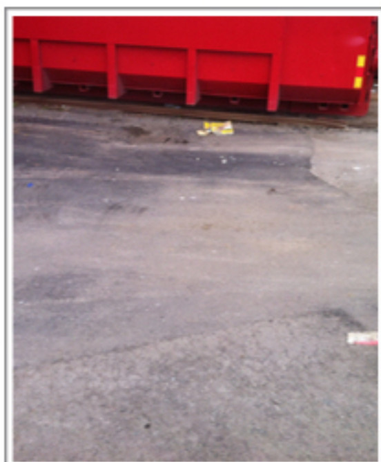
Vy mot RB4 d400 btg vid container rampen.
