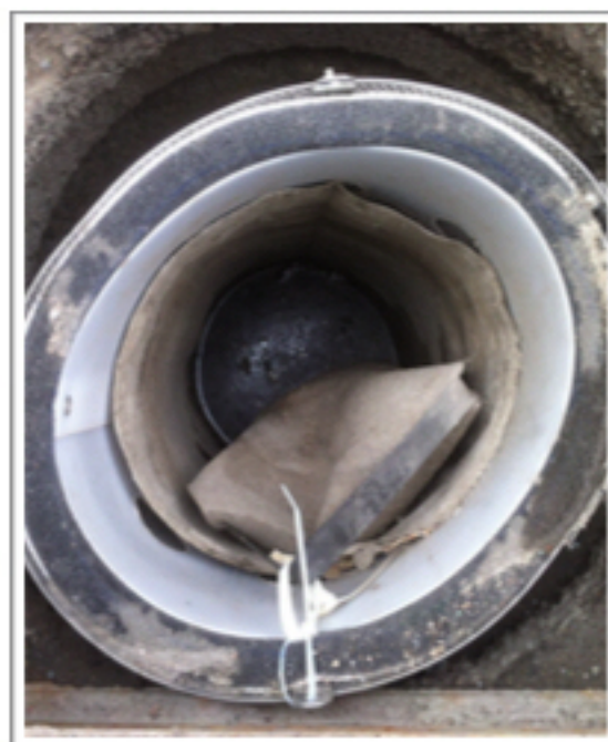
Vy ner i RB1 med SPL315 filterenhet.
