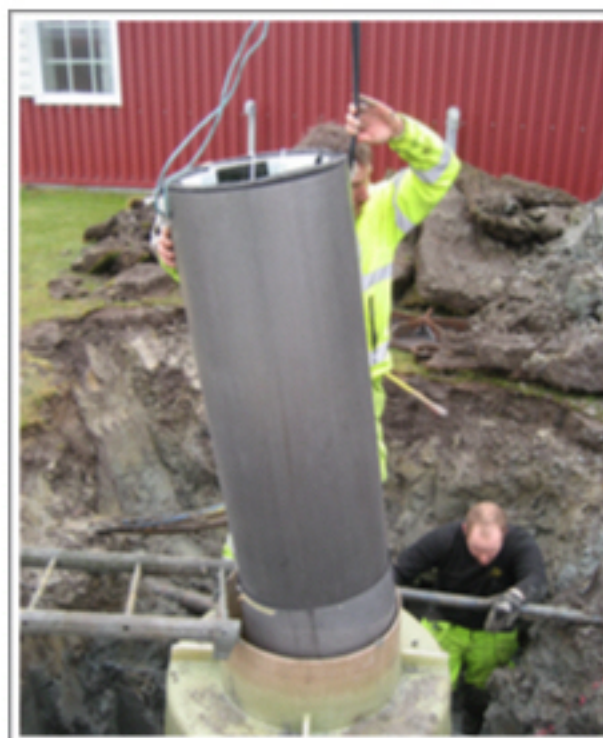
Filterenheten lyfts ner i GAP Dn 600 mm hålet till botten. 2 * Dn 110 rören ansluts.
