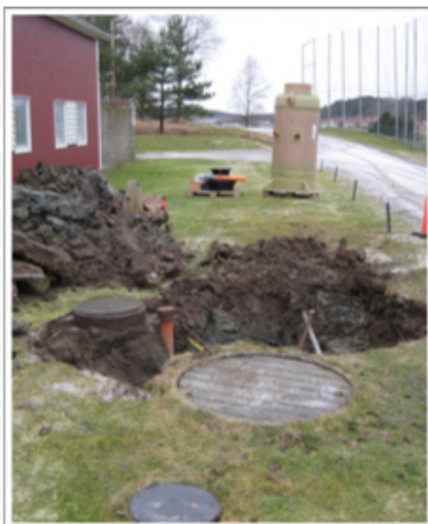
Bef. klass 2 oljeavskiljare till vänster med järnlocket+luftare. Trälock på pumpbrunn
