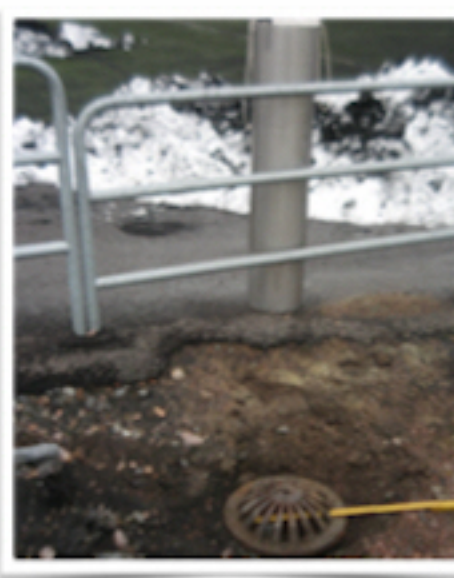
Bild: Annika Malmberg håller dagvattenfilter skydd "AVAK SPL 255" till brunn dn 400 mm.
