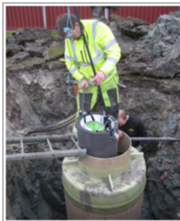
Filterenheten lyfts ner i GAP Dn 600 mm hålet till botten. 2 * Dn 110 rören ansluts.
