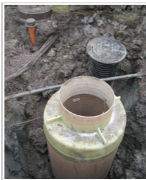
GAP 1000 brunnen monterad och inkopplad efter flytslam spärren i d 400 brunnen.
