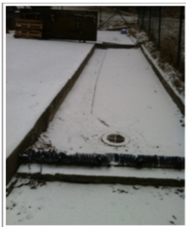
Spolplatta 2 ombyggd med spygatt.
