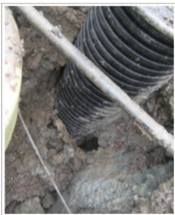
Flytslam spärren med d 400 brunn. Kopplas in efter klass 2 oljeavskiljare
